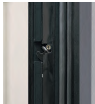
Der Verschluss mit pferdekopfförmiger Verriegelung im Rahmen
